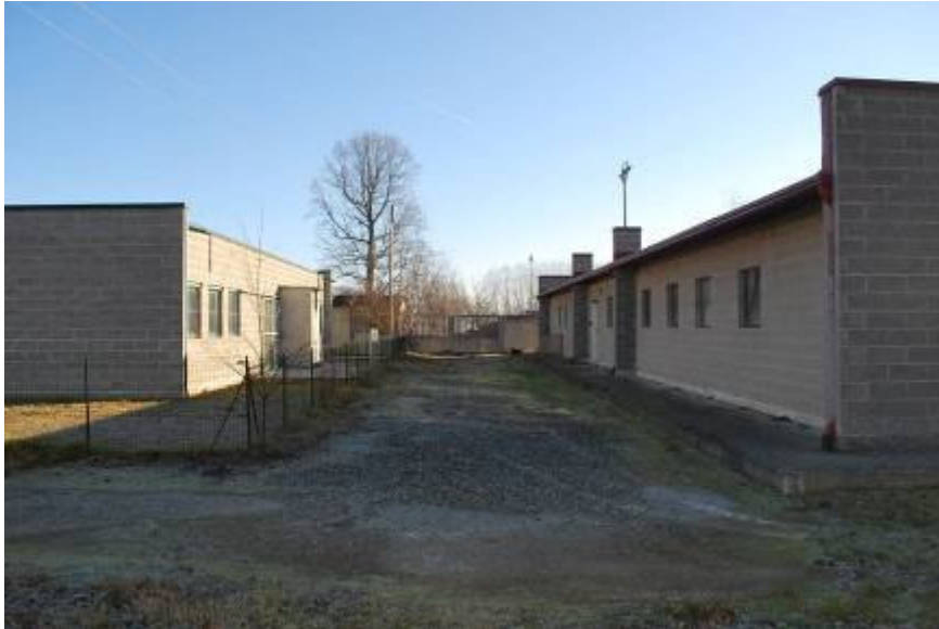
Foto 22 – vista su retro spogliatoi
