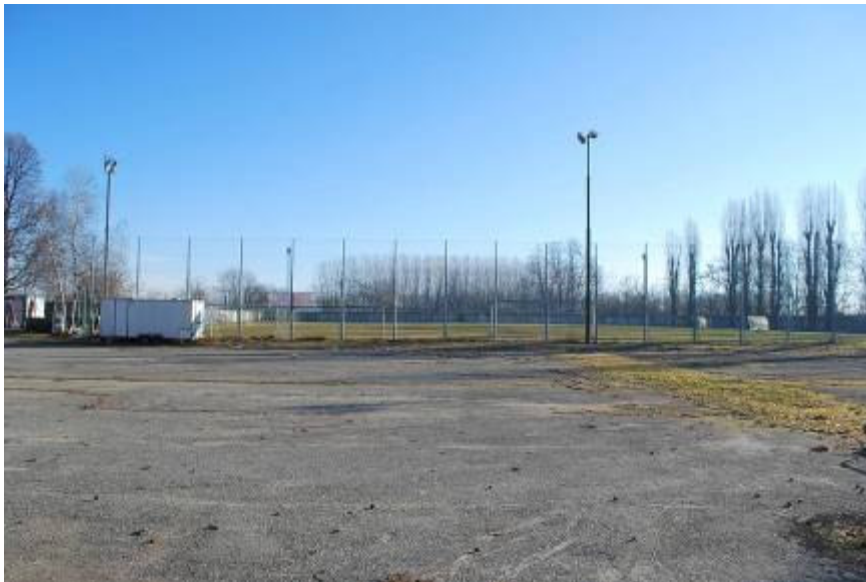
Foto 14 – piazzale pavimentato antistante gli spogliatoi
