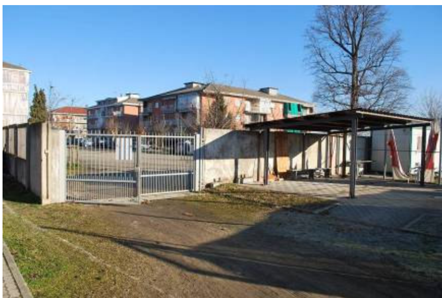
Foto 2 – ingresso principale agli impianti sportivi
