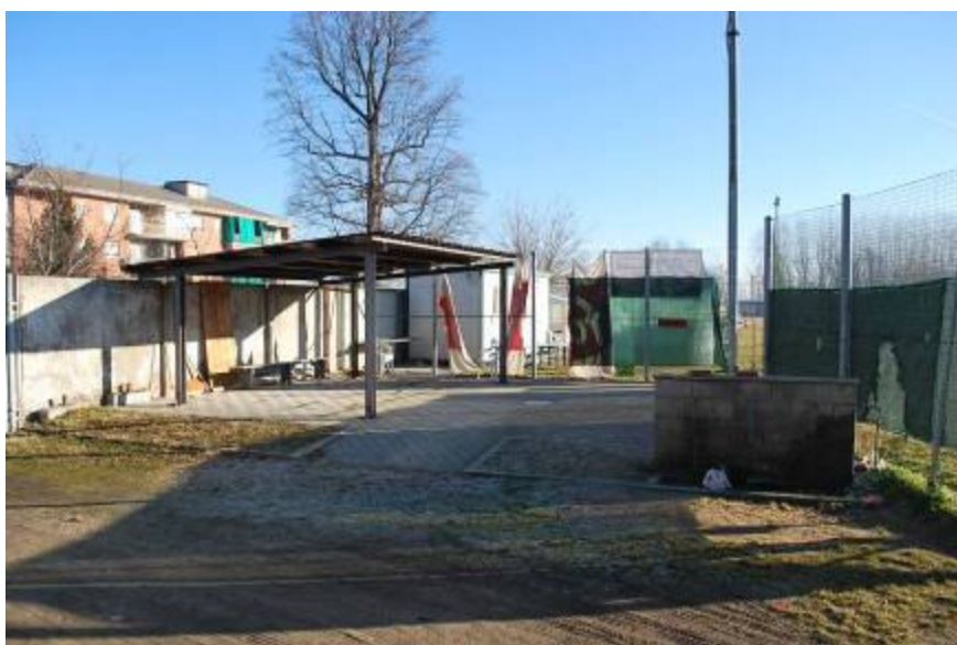
Foto 3 – tettoia deposito attrezzi e lavascarpe
