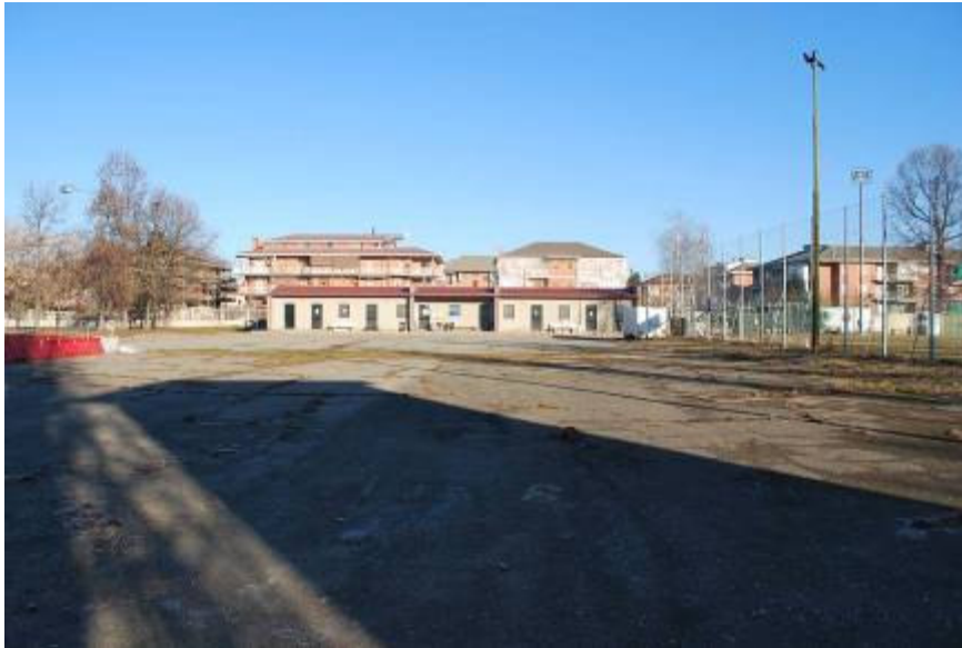
Foto 13 – piazzale pavimentato antistante gli spogliatoi
